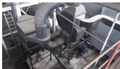
л) котлара за производство на пареа, котел - Тип SBK / HYBRID 6 кој како гориво користи пелети
