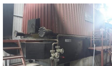
л) котлара за производство на пареа, котел - Тип SBK / HYBRID 6 кој како гориво користи пелети
