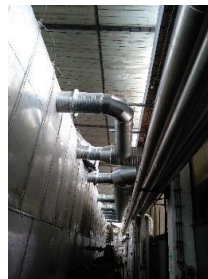
з) сушење на хартија со помош на пареа
