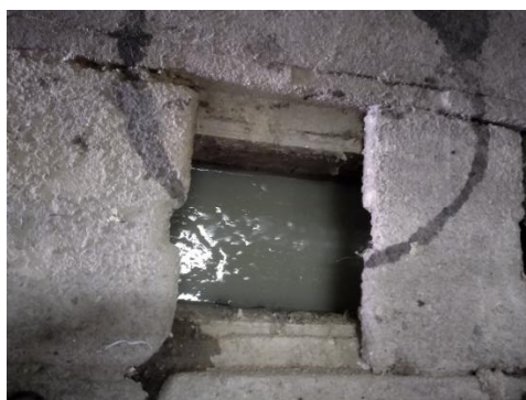
Канал за отпадни технолошки води во произведен погон
